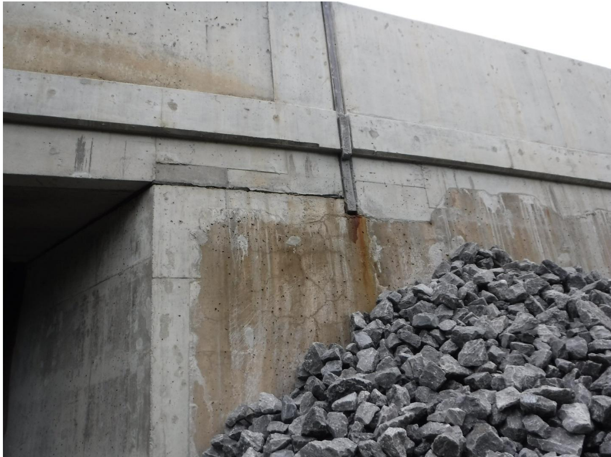
Figure A.11 (d) Ethylene Vinyl Acetate Seal
