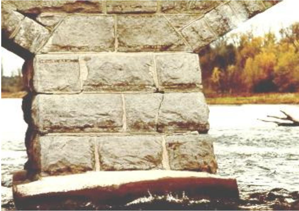
Figure A.12 (d) Masonry Pier
