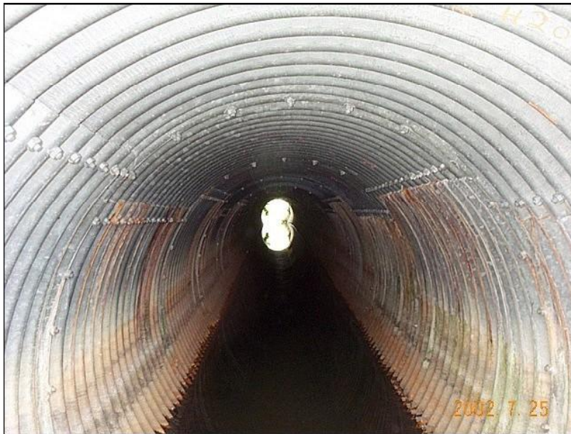
Figure A.7 (d) Multi-Plate Pipe Arch
