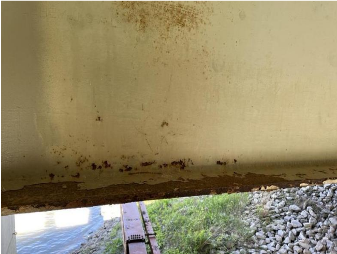
Figure A.4 (d) Steel Girder
