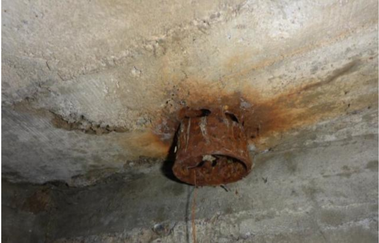
Figure A.8 (d) Deck Drain
