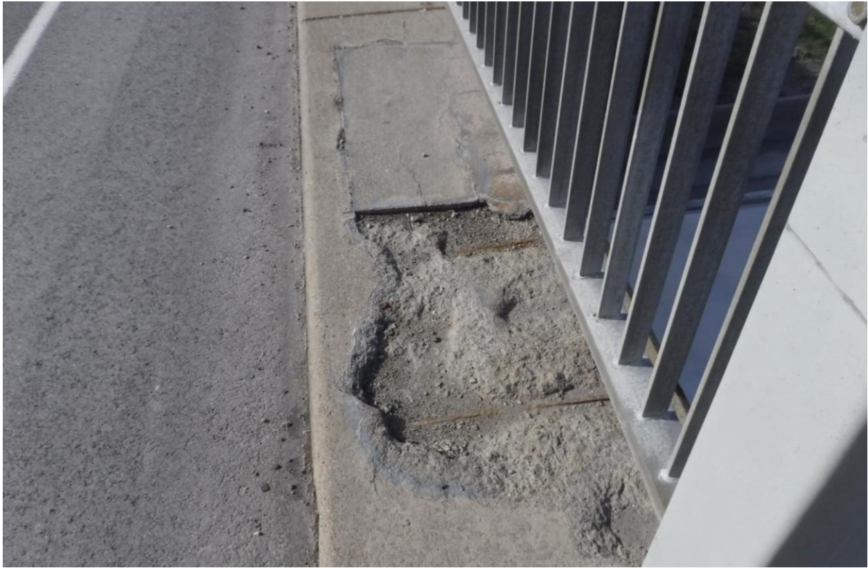
FigureA.2 (d) Concrete Sidewalk
