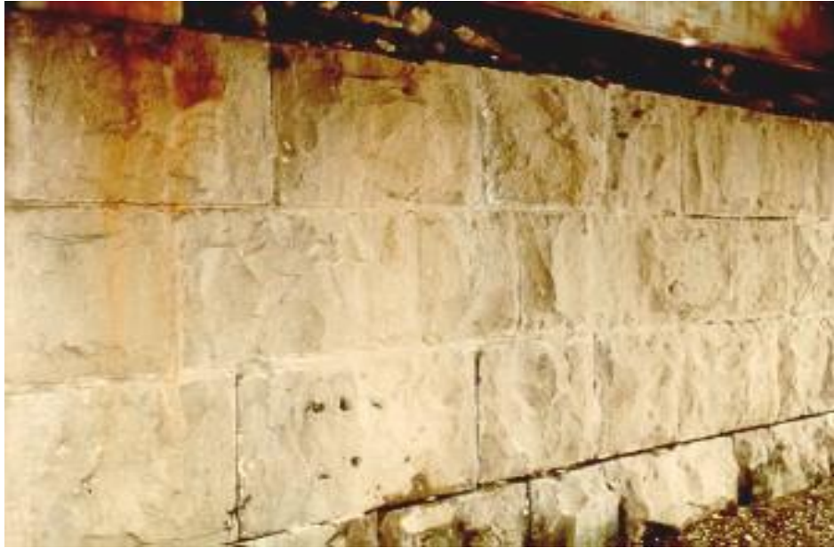
Figure A.1 (d) Masonry Abutment Wall
